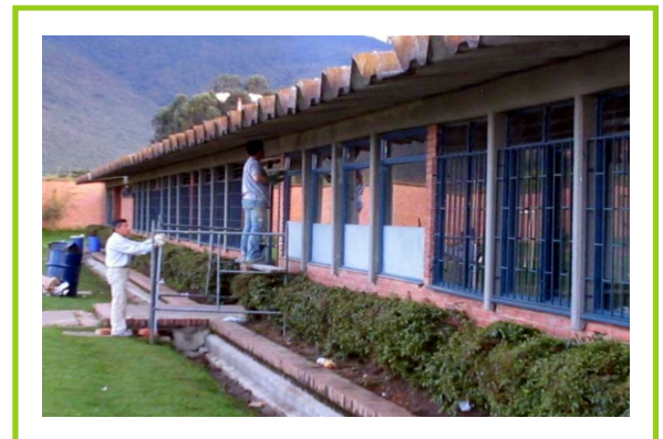
Instalación de Ventanería Acústica y remate de muros contra cubierta
